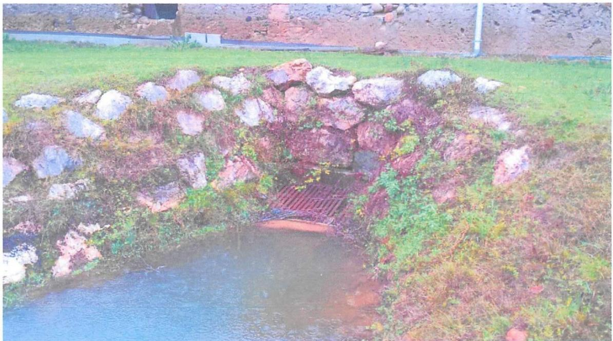
Figure 5 : Entonnement de la conduite
